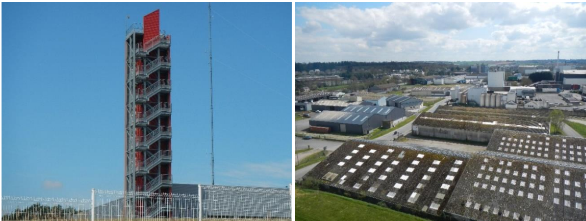
Figure 2 : Tour du centre de secours (Pontivy) et aperçu de la vue depuis son sommet Photos TBM environnement
