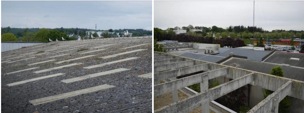
Figure 6 : Aperçu des toits des entreprises SKIOLD/ACEMO (à gauche) et Bureau Vallée, Norauto (à droite) en 2019 – Photos TBM environnement
