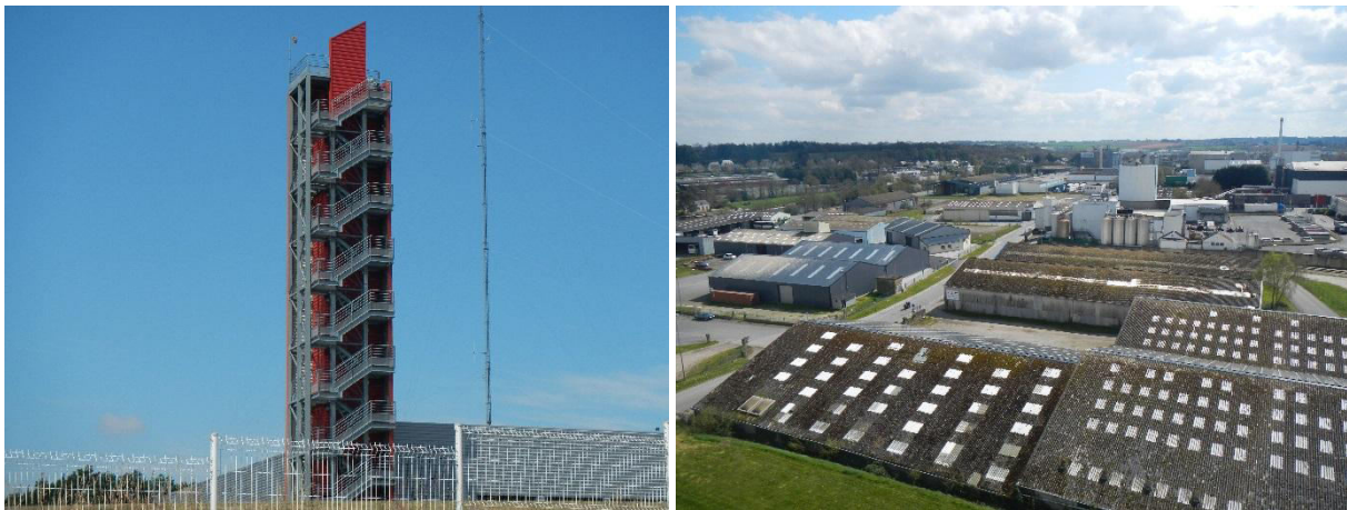
Figure 4 : Tour du centre de secours (Pontivy) et aperçu de la vue depuis son sommet – Photos TBM environnement
