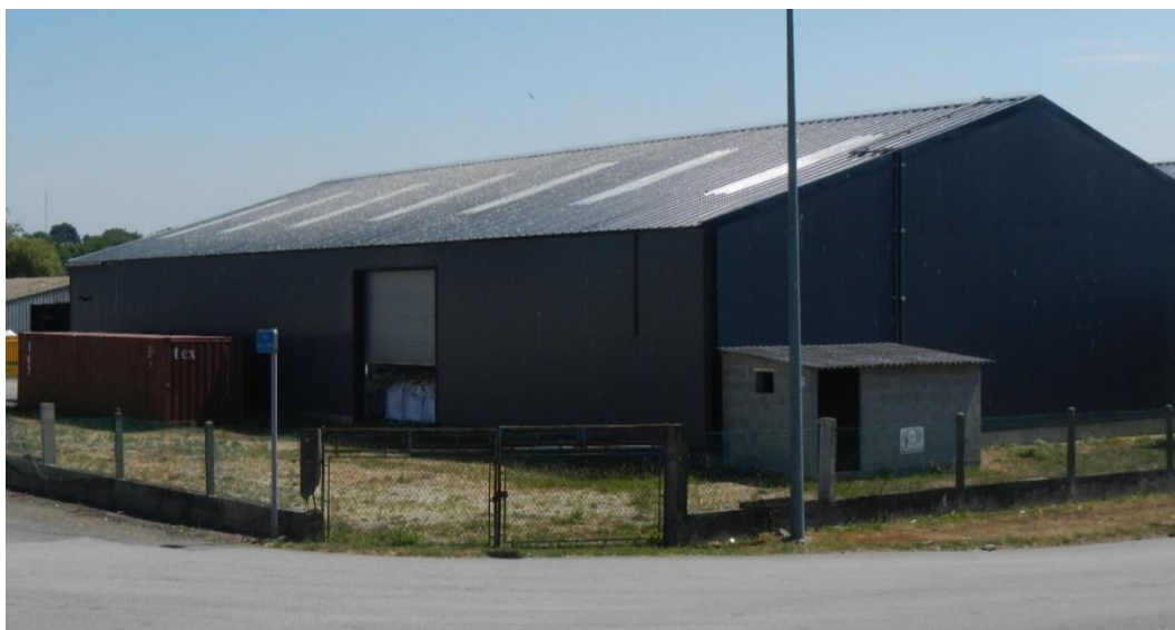
Figure 12 : Bâtiment avec toit en fibrociment rue Denis Papin (Le Sourn) occupé par quatre nids en 2016 (en haut) - Image Google StreetView - et après installation d'un toit en bac acier en 2017 (en bas) – Photo TBM environnement
